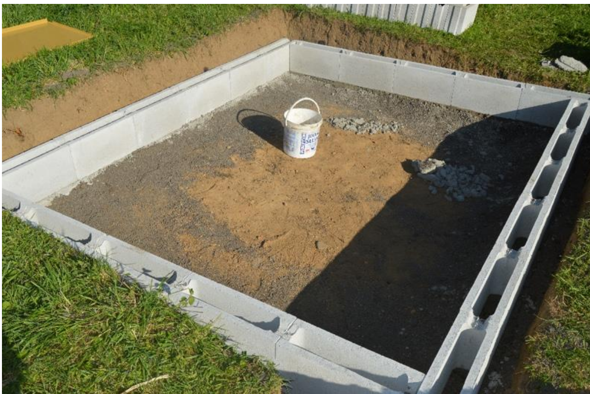
Kombinace betonového lože a ztraceného bednění.
