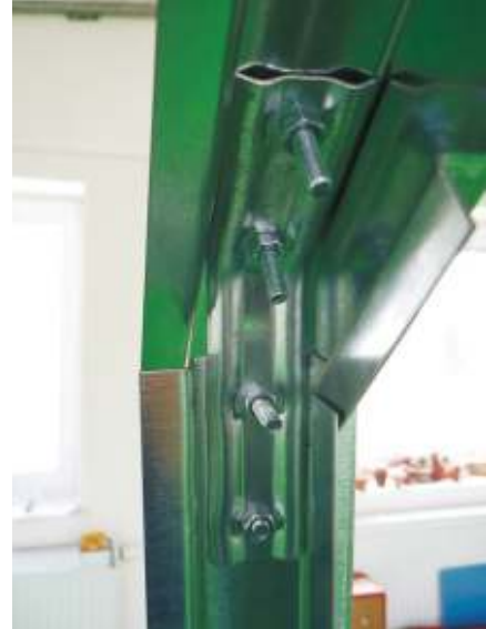
Montáž horního pravého rohového (střešního) sloupku (poz. 7, 9, 55 šrouby M6x25) Detailní pohled.
