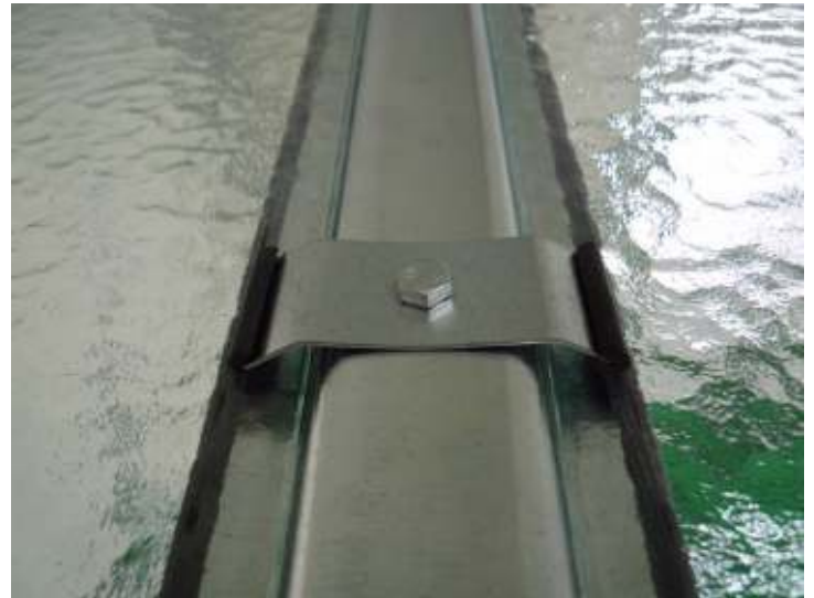
Přichycení střešního skla příchytkou poz. 83-2. Pod tyto příchytky můžeme zevnitř skleníku umístit vyvazovací pásy, pozice 84-2
