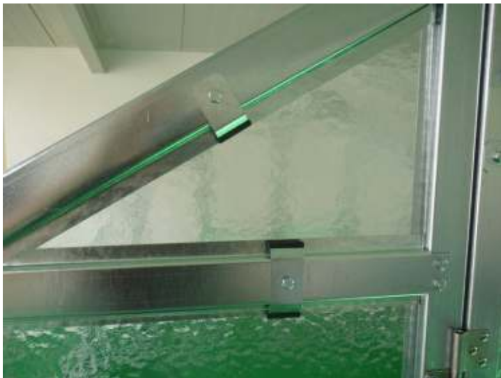
Přichycení skla k pozici 72 příchytkou 83-1 a 83-2
