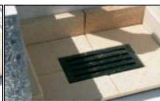
15. Vložení litinového roštu do topeniště
