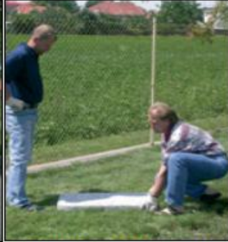
3. Položení základové desky na vyrovnanou plochu
