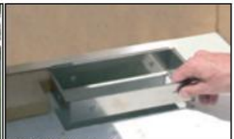
12. Uložení rámu nerezového popelníku
