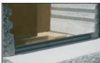
13. Usazení ochranného nerezového plechu na hraně topeniště
