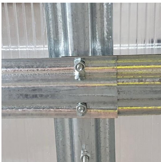
Obr. 2 - detail D (pohled zevnitř skleníku)
