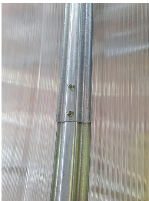
pohled z vnitřní strany skleníku na detail B
