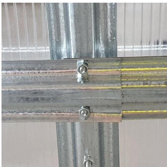
detail F (pohled zevnitř skleníku)
