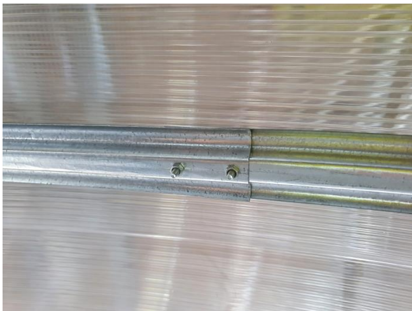
pohled z vnitřní strany skleníku na detail 1
