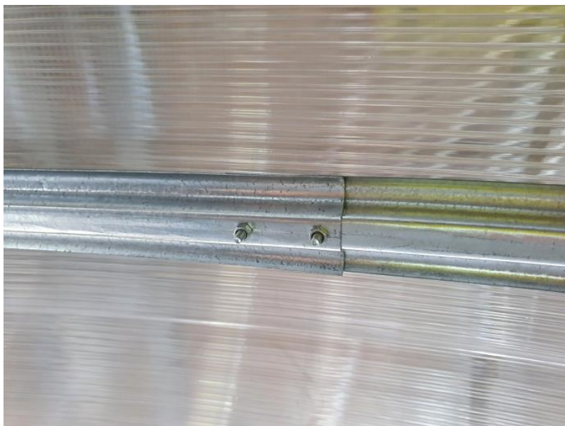
pohled z vnitřní strany skleníku na detail 1
