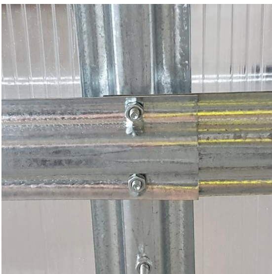
detail F (pohled zevnitř skleníku)
